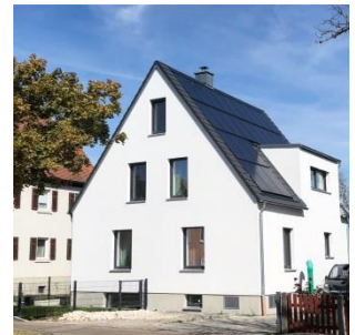
Altbausanierung zum EffH. 40+
